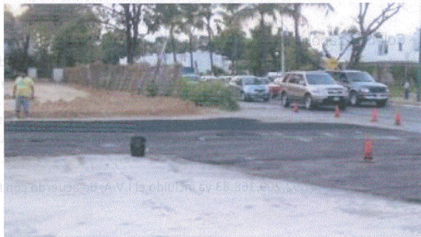
Ilustración 26. Restitución total de la calle. (Fuente: SIAPA)
