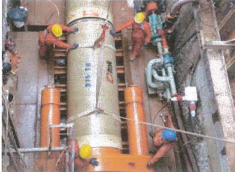
Ilustración 24. Empuje de tubería desde la lumbrera de acceso
