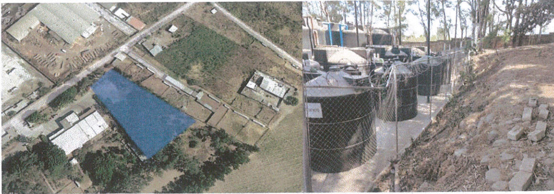
Ilustración 3. PTAR Cd. Industrial. (Fuente: propia)
