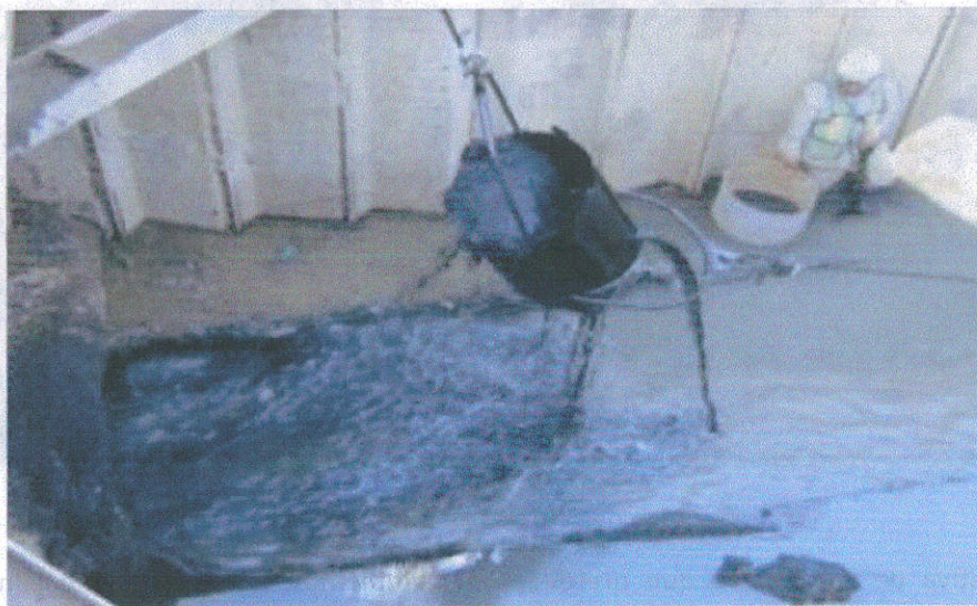
Ilustración 23. Desazolve de Colectores o Emisores. (Fuente: SIAPA)
