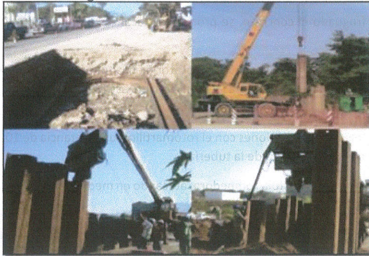
Ilustración 21. Construcción de Lumbrera. (Fuente: SIAPA)
