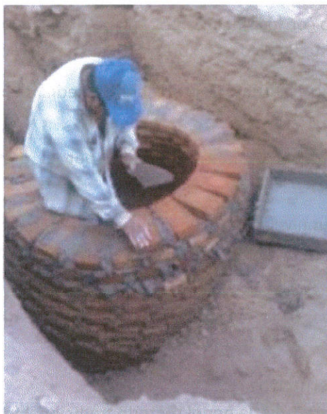
Ilustración 17. Construcción de Pozo de visita. (Fuente: SIAPA)
