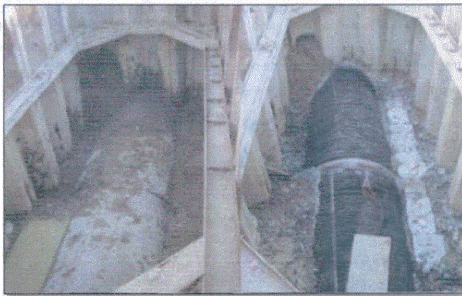
Ilustración 22. Abertura del colector existente. (Fuente: SIAPA)
