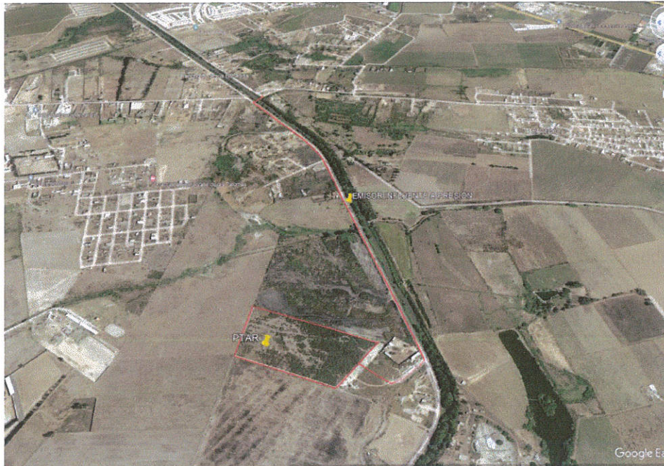
Ilustración 1. Localización PTAR Xalisco. (fuente: google earth)
